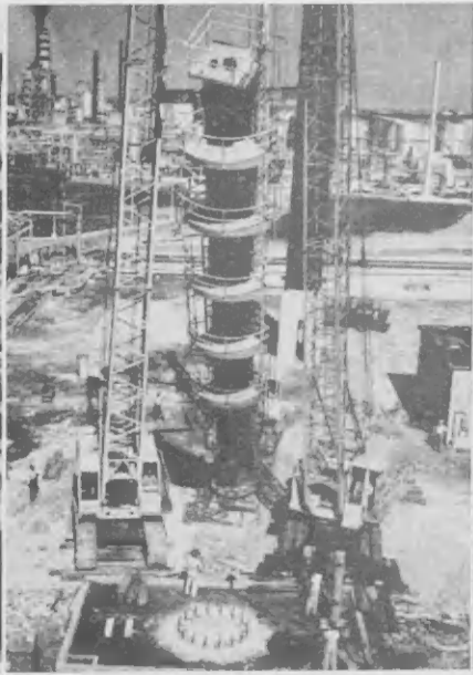
RIGGERS RECIENTEMENTE a pone tres grua di binti-cinco ton capacidad na trabao recientemente pa hiza e tower aki di cincuenta ton cual lo purifica feed gas pa e planta di amonia di A.C.C. E trabao tabata leuw for di rutina. E torre mester a worde lamtá mientras e ta equipá cu plataforma, trapi y cable.
